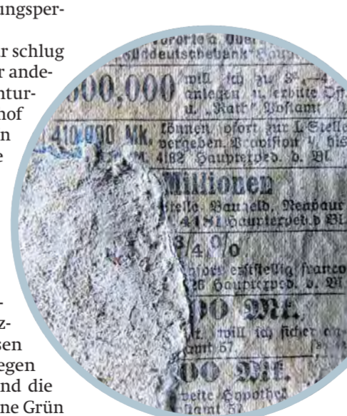
Entblättert: Es hat seine Vorteile, dass früher immer Zeitungen als Tapetenunterlage verwendet wurden. Man kann noch heute nachvollziehen, wann tapeziert wurde.
