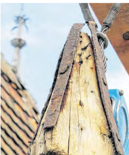
• Links Heute ein Kaiser: Das einzige, was vom alten Dachstuhl des Treppenturms noch zu retten war, war der sogenannte Kaiserstiel - eine ausgefellte Konstruktion, die für optimalen Zusammenhalt der Dachsparren sorgt.
