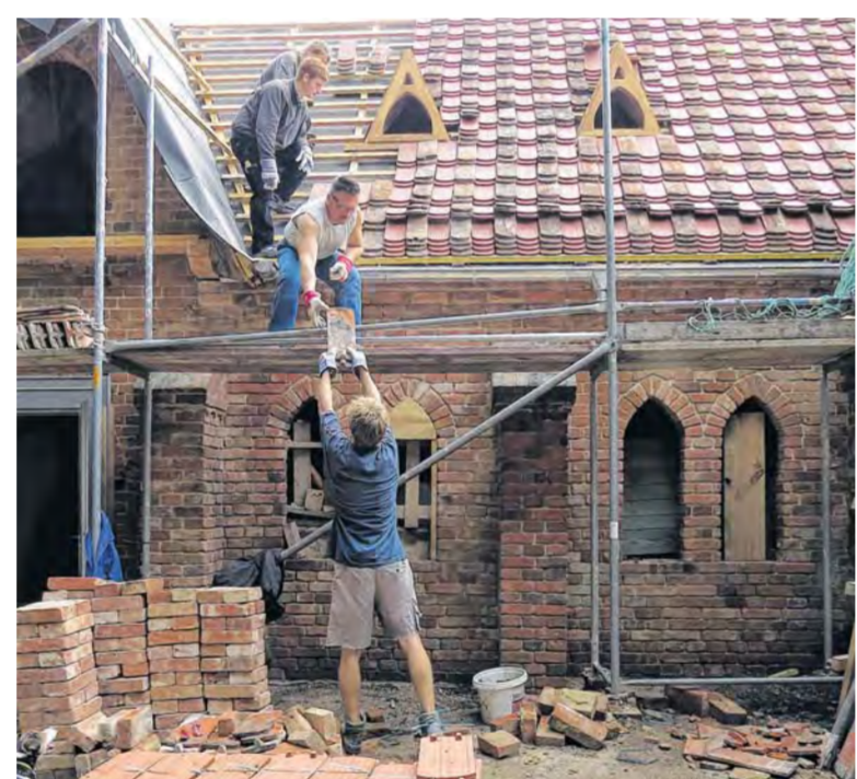
G(l)auben(s)frage: Es forderte Dachdeckern wie Zimmerleuten einiges ab, die nach altem Vorbild neu entstandenen Gauben auf dem hinteren Flügel der Anlage wieder in die originale Position zu bringen.
