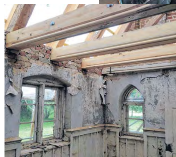
• Unten Neuanfang: Der hintere Flügel des Gutshauses - am längsten bewohnt und am besten erhalten - ist zuerst gesichert und saniert worden.
