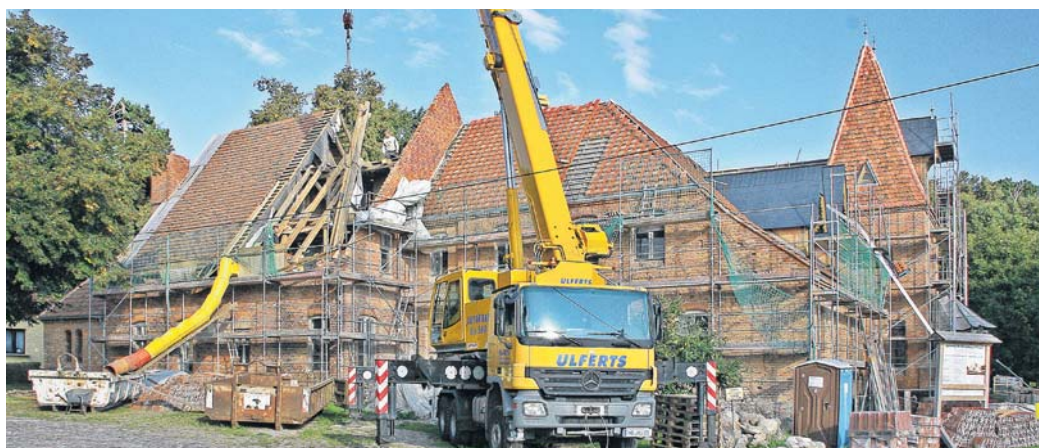
Zweimal heult die Motorsäge, dann hebt der Kran die Dachsparren ab und lässt sie zu Boden. Hier zeigt sich, dass der größte Teil des Holzes wurmzerfressen und vermodert ist. FOTO: S. HAERTER
