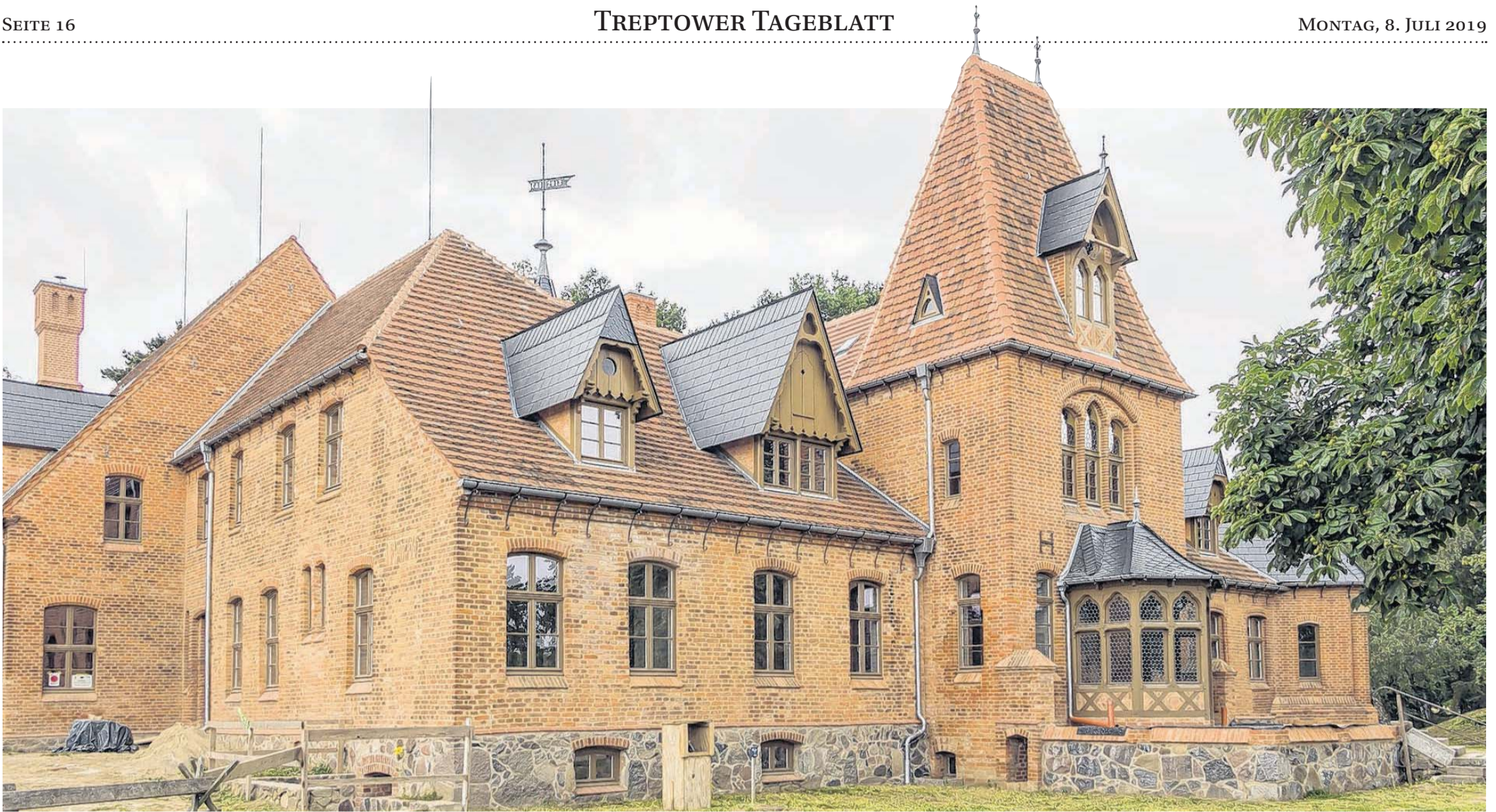
Der totgeweihte Patient zeigt sich nach sieben Jahren Sanierung so vital wie schon lange nicht mehr: Das Pinnower Schloss ist überm Berg und braucht „nur“ noch zwei Jahre Baubehandlung.
