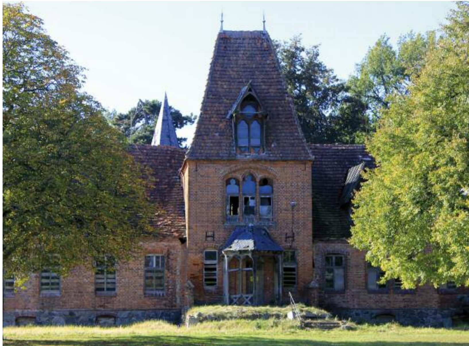
Gutshaus Pinnow: Das ungewöhnliche Herrenhaus von 1869 ist vom Verfall bedroht Bilder: www.schloss-kaufen.com, www.gutsdorf.de
